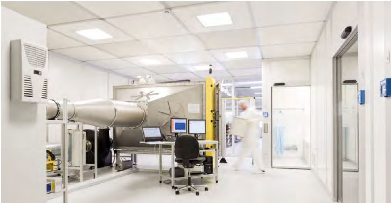
Gesamte Scantest-Anlage im werkseigenen Reinraum
