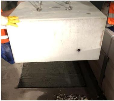
Abbildung 2.4 - Einbringung der Fundamente
